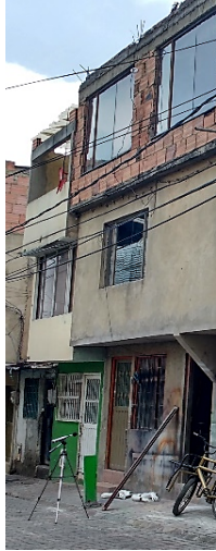
Foto No. 3 Punto Medición
